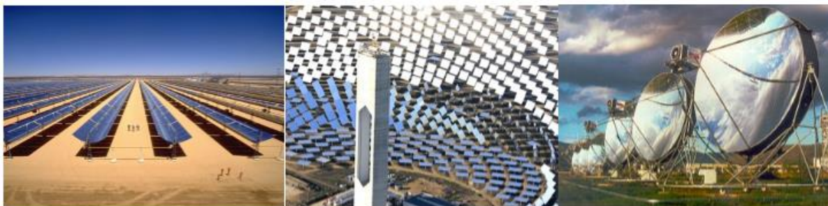
Слика 18 а) Фреснел концентратори; б) Хелиостати; в) систем со параболична чинија
